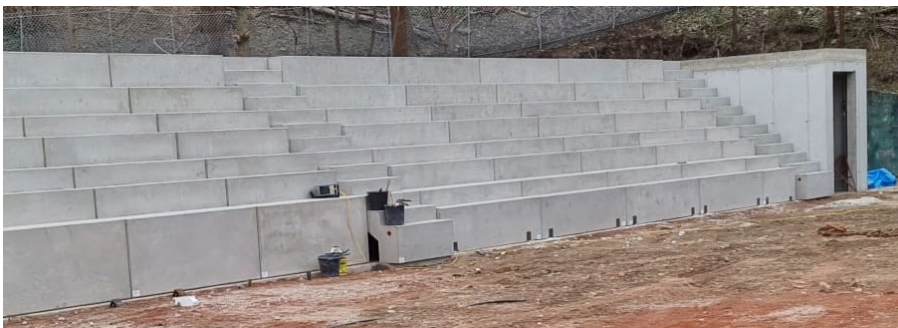
Die Sonderfertigteile von Rauter weisen besondere Merkmale wie eine Breite von 139 bis 239 Zentimetern auf und wurden vor Ort von Rauter montiert. Jedes Fertigteil wiegt dabei etwa 10 Tonnen.
