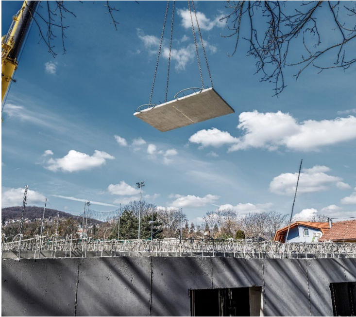
Versetzen eines MABA Klimadeckenelements beim Bau des Bundesleistungszentrums Ost, 1170 Wien.
