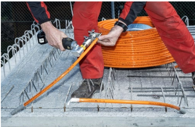
Installation, Funktionsüberprüfung und Anschluss der Leitungen
